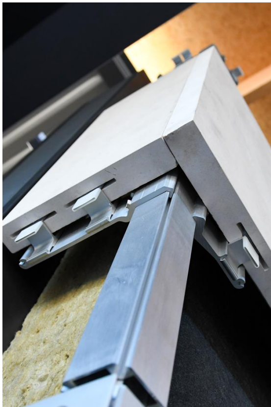
Detail Einzelanker Detail single anchors
